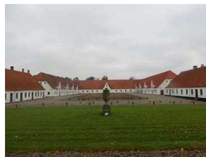
Avlsanlægget set fra øst.
